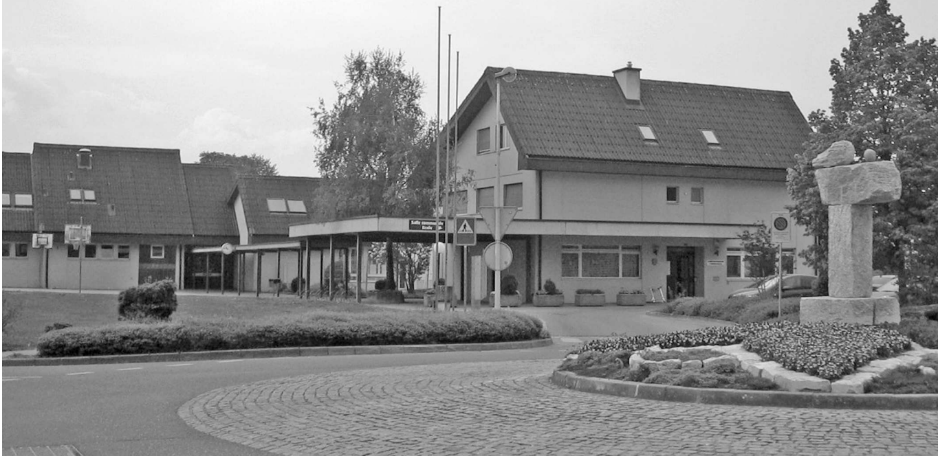
Sur la droite, le bâtiment qui abrite le bureau communal
